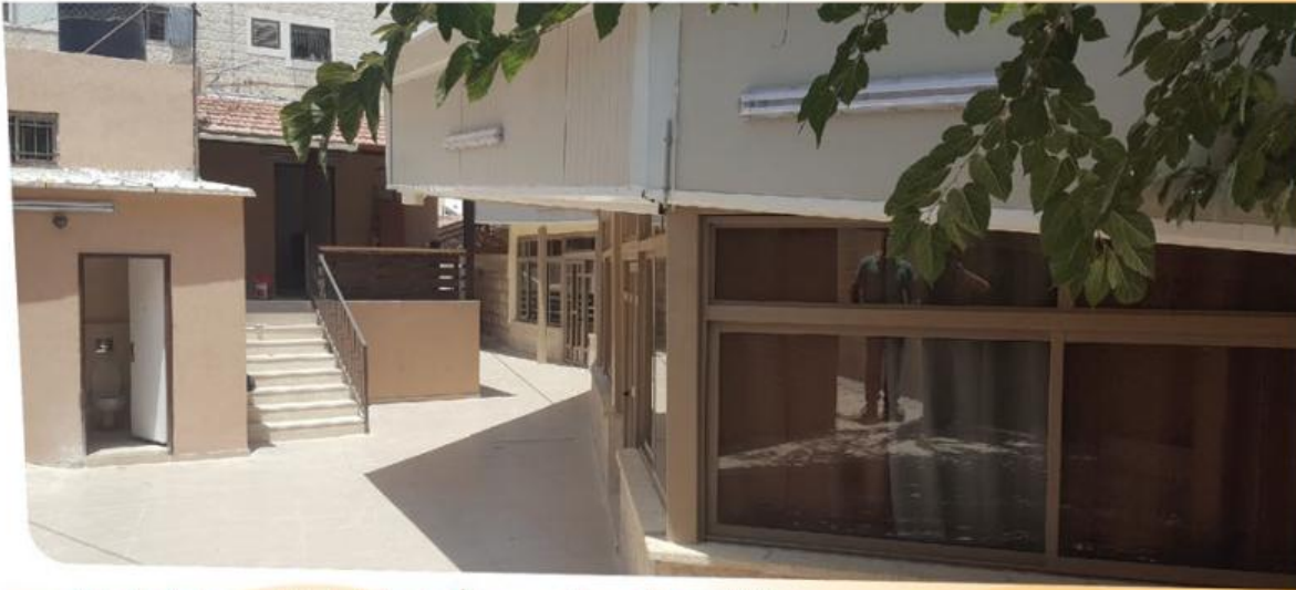
إختتام مشروع ترميم وتأهيل شامل لنادي سلوان الرياضي.
