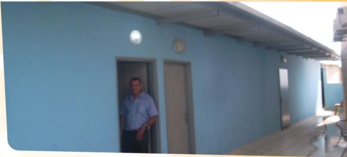
إختتام مشروع ترميم وتأهيل نادي العيسوية.
